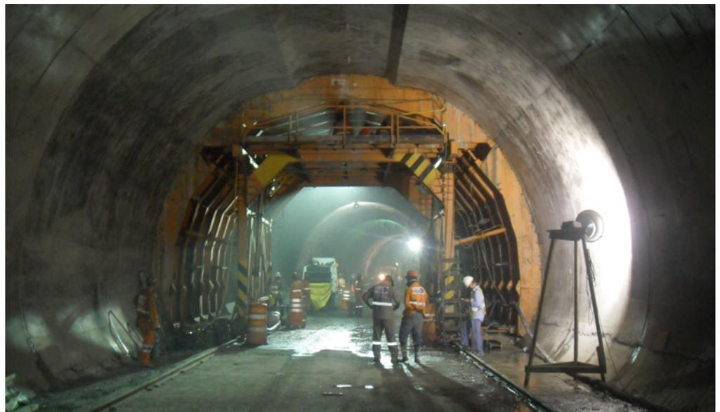
túneles creando un anillo de soporte de carga natural y reduciendo al mínimo la deformación de las capas circundantes de la roca. PENETRON ADMIX<sup>®</sup> se utilizó para reducir la permeabilidad de las paredes del concreto lanzado. PENE<sup>™</sup>BAR SW-55 se utilizó para sellar las juntas de construcción. En total, se utilizaron 45 toneladas de PENETRON ADMIX<sup>®</sup> y 2.300 metros de PENE<sup>™</sup>BAR SW-55.
